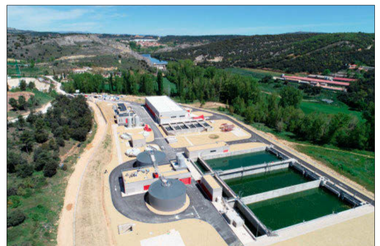
Vista aérea de la nueva depuradora. HDS
